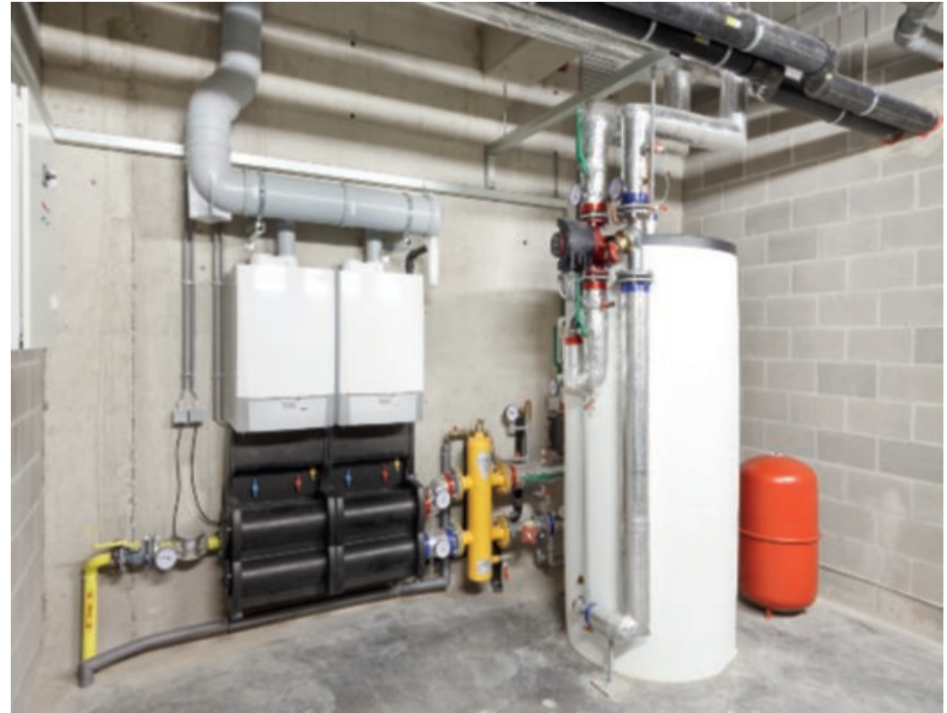
Remeha Quinta Pro in cascade in combinatie met een sanitair warmwaterbereider Remeha BP
